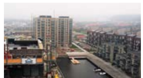
Die im Bau befindlichen Hochhäuser
